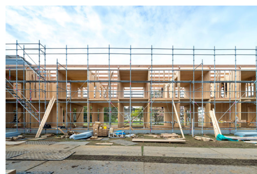
大賞「DLT木造仮設住宅」
