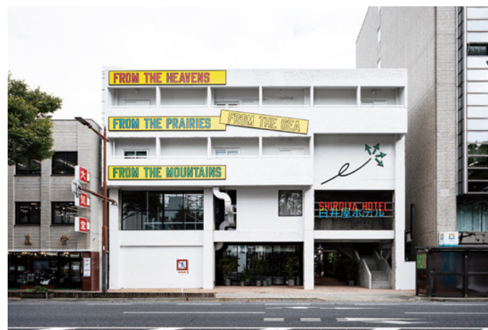
前橋市の変化の象徴とも言える、藤本社介の設計の「白井屋ホテル ヘリテージタワー」(左)と「白井屋ホテル グリーンタワー」。 ©Shinya Kigure
