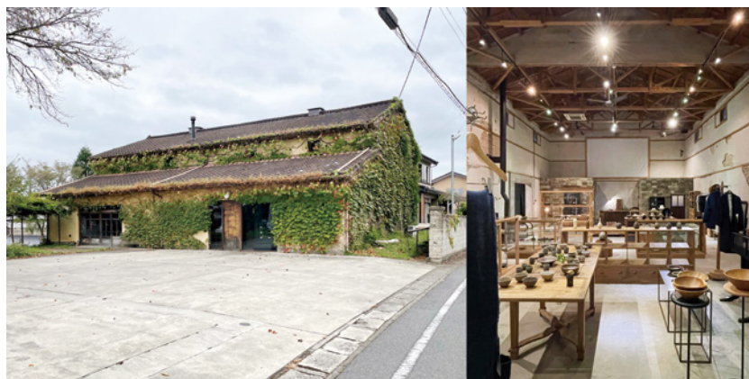
益子町旧市街地のセレクトショップ「pejite」。 ツタの絡まった古い石蔵を受け継ぐ営み。 写真提供:宇都宮大学
