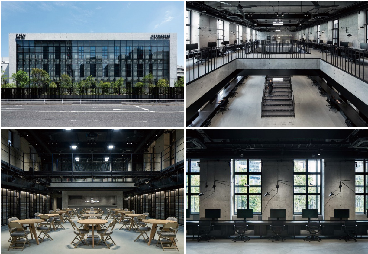
2023年5月に設立された新スタジオ「CLAY」。「完成しないスタジオ」をコンセプトに、外観やインテリア、サイン、音響などあらゆるデザインは社内で考案された。このデザイン拠点と、IT開発拠点「ITs」の2棟で構成される「FUJIFILM Creative Village」から、同社は新たなイノベーション創発を目指す。
